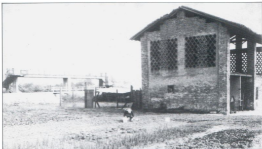
Casinel dal Birloc (sullo sfondo la conca)
