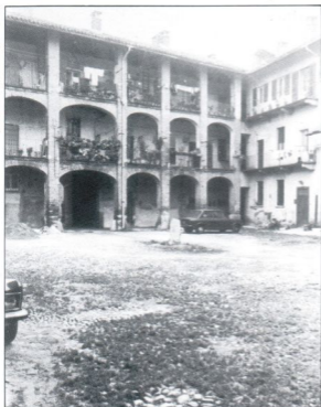
Cortile di Via Pilastrello 44
