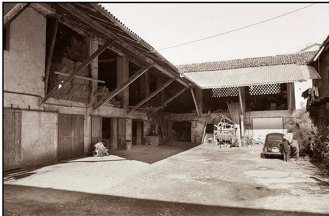
Qui sopra: l'orditura di travi lignee utilizzata per sorreggere il tetto, tipica della cascina lombarda
