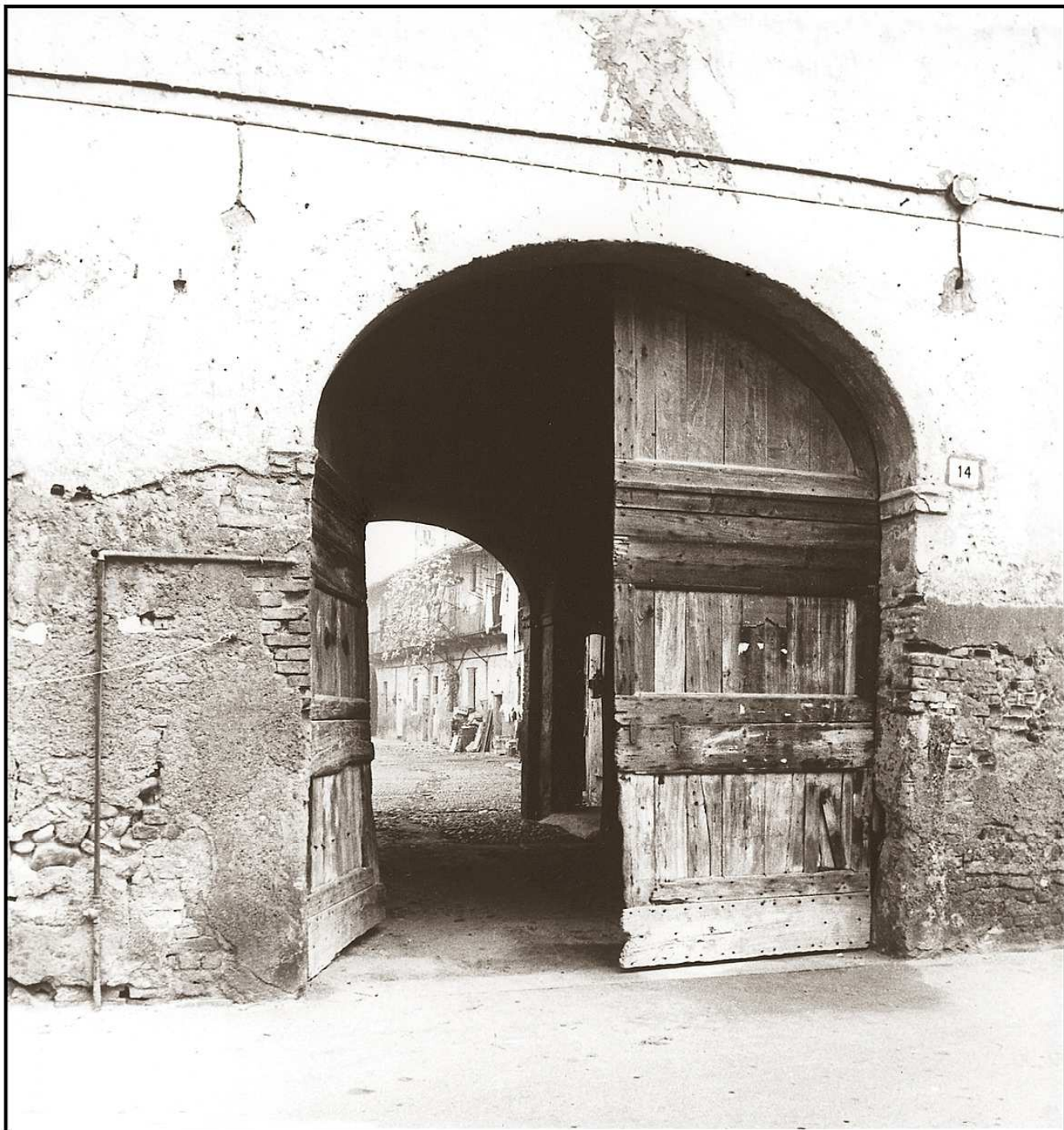
Il portone di ingresso della Curt lunga (fronte verso il naviglio)
