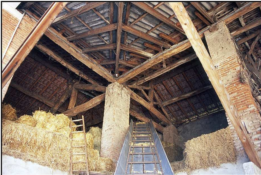
Qui sopra: l'orditura di travi lignee utilizzata per sorreggere il tetto, tipica della cascina lombarda
