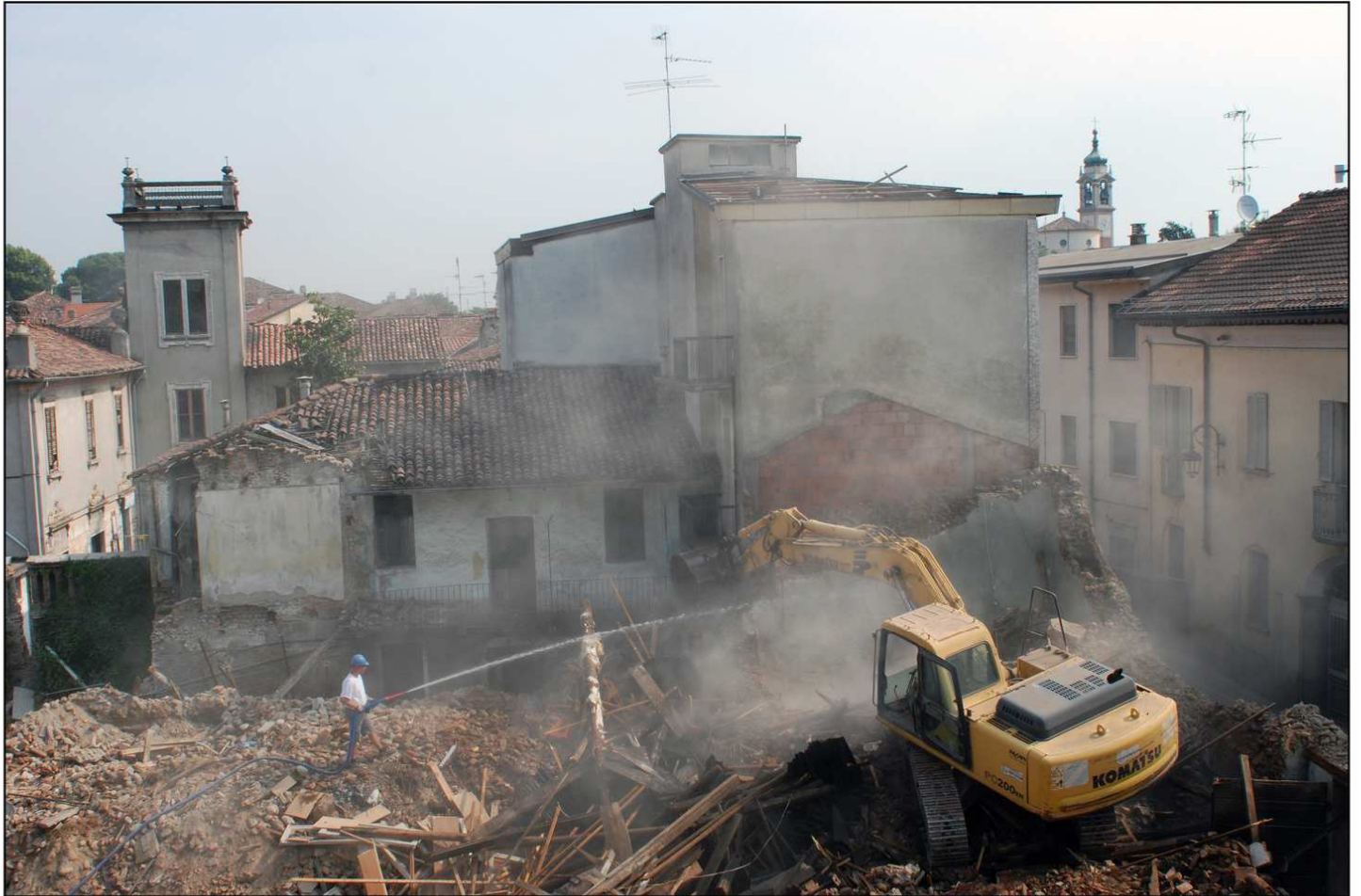
Abbattimento cortile di via Marchesi.
