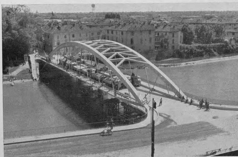
Fig. 12 - Il nuovo ponte visto da monte durante le prove di carico.
