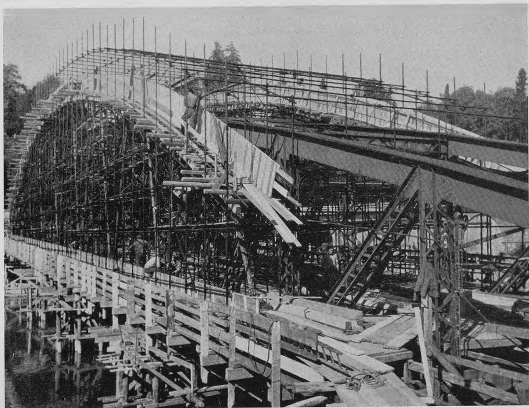
Fig. 3 e 4 - Sopra: Il camminamento pedonale ultimato. Sotto: Centina tubolare in ferro ed esecuzione della carpenteria degli arconi.
