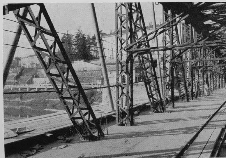
Fig. 7 - Getto dell'impalcato (3ª fase).
