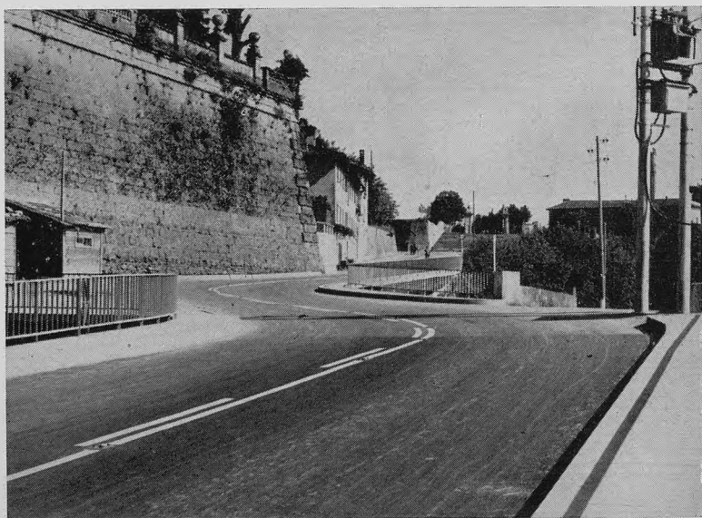
Fig. 14 - La strada in sponda milanese in corrispondenza al ponte sul Naviglio Martesana dopo l'ampliamento.
