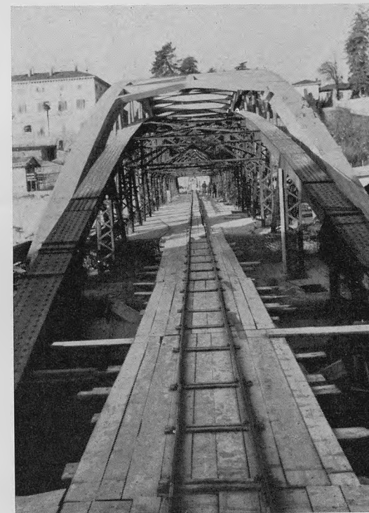
Fig. 8 - Getto dell'impalcato (3ª fase). Il vecchio ed il nuovo ponte visto dalla sponda di Canonica.
