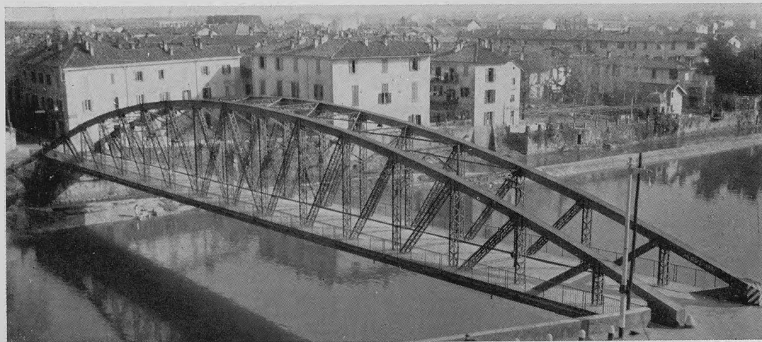
Fig. 2 - Il ponte in ferro rimasto in esercizio sino al 9.12.1954.
