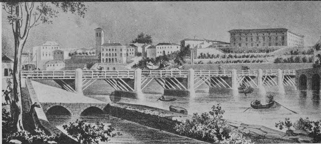
Fig. 1 - Il ponte esistente anteriormente al 1867.
