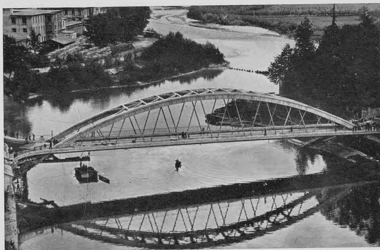
Fig. 11 - Il nuovo ponte visto da valle.
